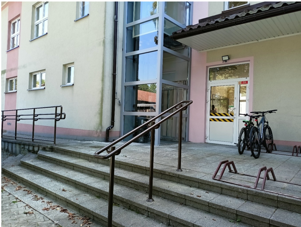
Wejście z tyłu budynku przy windzie
